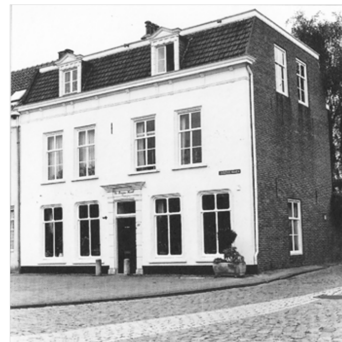
De Bruyne Hondt was het eerste pand dat door Stadsherstel werd gerenoveerd.
